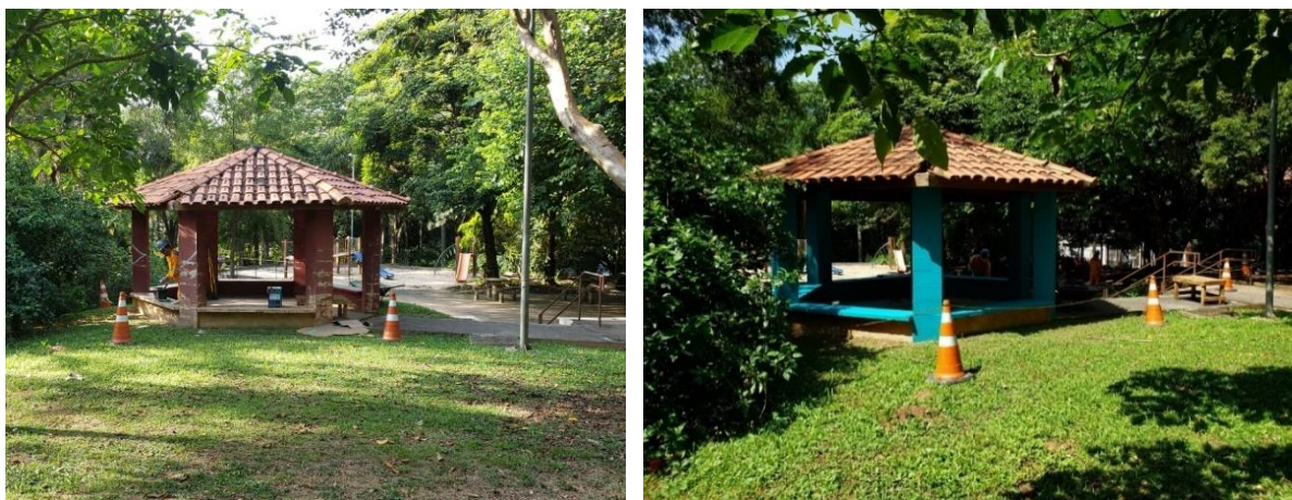
Figura 16: Manutenção nos quiosques (Antes e depois)
