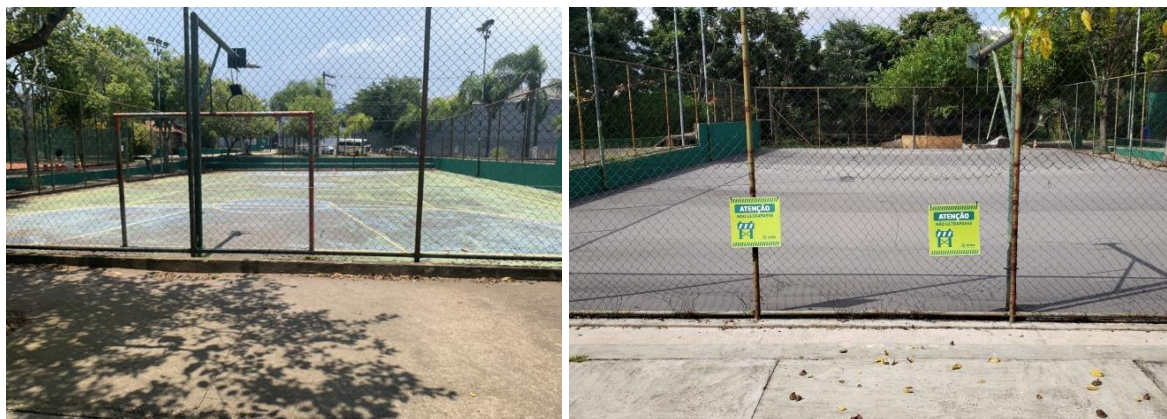
Figura 20: Manutenção da quadra
